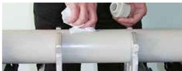
Navařovací sedlo s vnějším závitem
